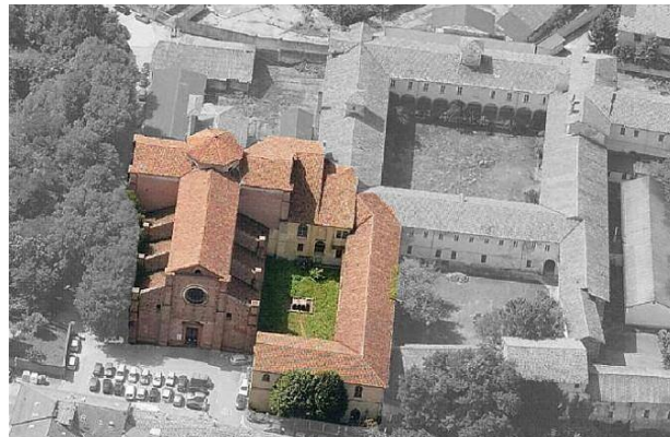
TECNICO EDILE SPECIALIZZATO PER IL CANTIERE PER IL RESTAURO E CONSERVAZIONE DELLE SUPERFICI DI PREGIO DELL'EDILIZIA STORICA
